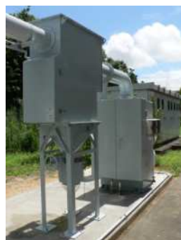
(爆発試験時の排気ガス処理装置)
