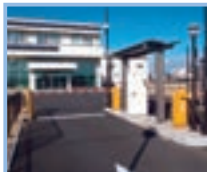
駐車場・セキュリティゲートシステム
