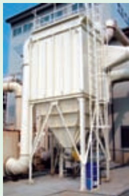
WRT大型集塵機設置例
