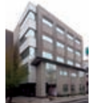
アマノ第2ギャラクシービル ●アマノマネジメントサービス株式会社 ●アマノメンテナンスエンジニアリング株式会社 ●アマノタイムビジネス株式会社
