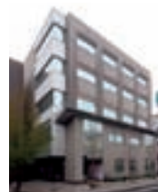
アミノ第2ギャラクシービル ●アミノマネジメントサービス株式会社 ●アミノメンテナンスエンジニアリング株式会社
