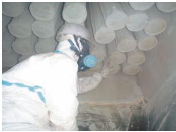
機器の保守・点検・再生
