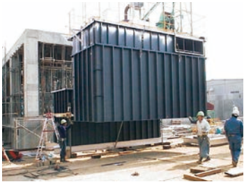
環境改善機器設置工事業
