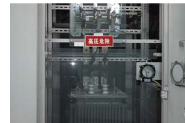
老朽化した変圧器を更新し、効率的な電力供給を実施(細江事業所)
